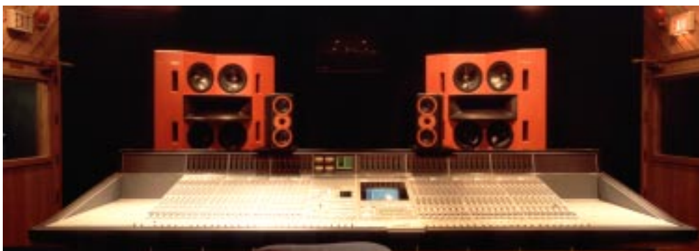
AVATAR STUDIO-D (NY, 1999) メインモニターはWARP-7。WARP-7はV-4 (Vertical Quad) 中最大のスピーカーで、20Hz 20kHzをフラットに再生する。ドライブアンプはKinoshita-JMF最大のHQS4200UPM。さらにスモールモニターはKM1Vである。2chステレオのレコーディングスタジオであるが、スケールの大きな音場や、立体的で明瞭な音像表現が刺激となり、アコースティックレコーディングへの回帰も見られる。今後の音楽に大きな影響を与えることになるだろう。
